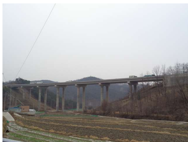
5공구 오실교 (5공구)
