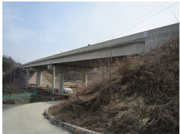
9공구 도림천교 (9공구)
