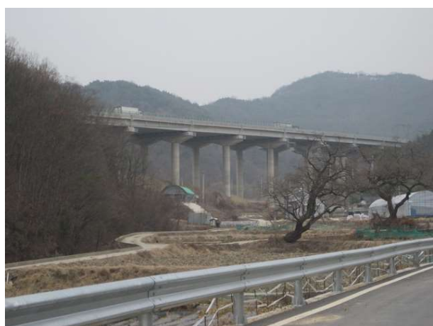
5공구 오로교 (5공구)
