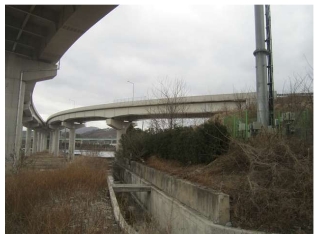
10공구 영천JCT Ramp-B교(10공구)
