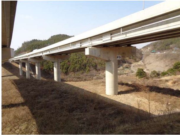
5공구 불당교 (5공구)
