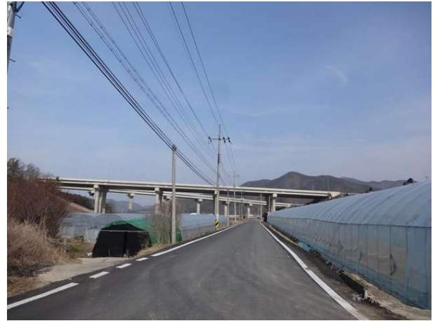
5공구 내리교 (5공구)
