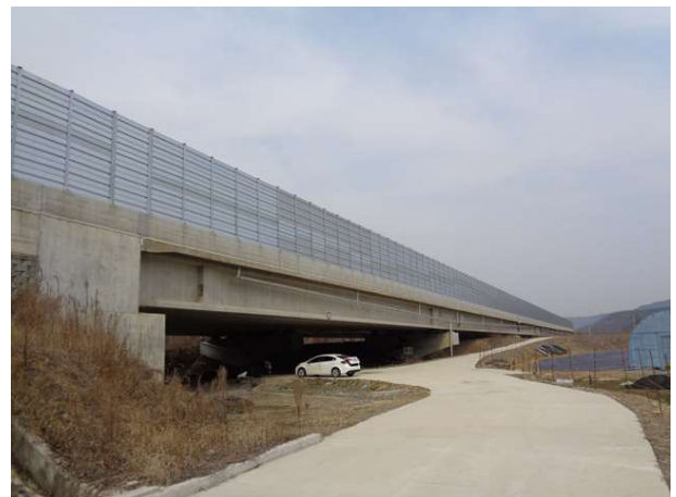
6공구 금매교 (6공구)
