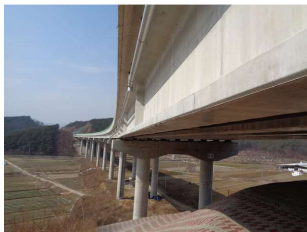
3공구 도개교 (3공구)
