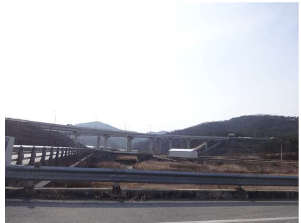
5공구 군위JCT R-C교 (5공구)
