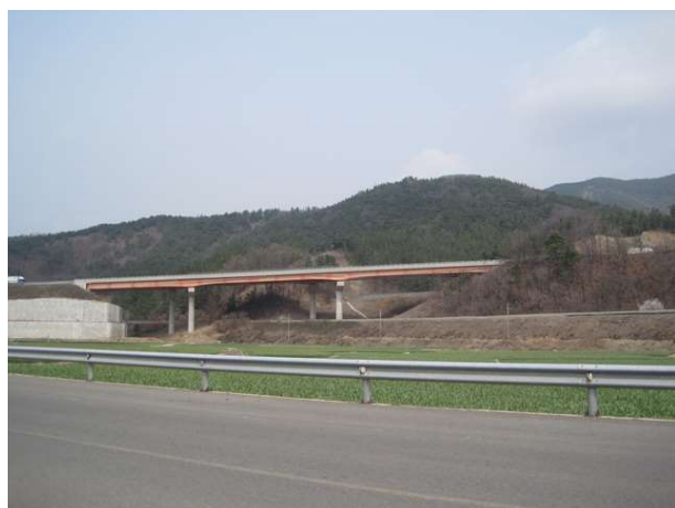
7공구 화남교 (7공구)
