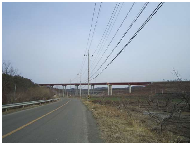
8공구 화산JCT RAMP-A1교(8공구)
