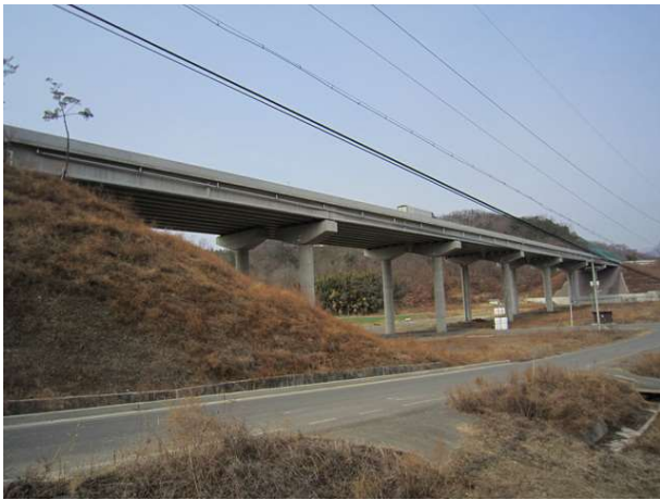
9공구 가래실교 (9공구)
