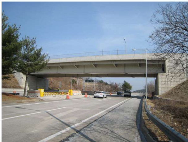
5공구 군위JCT R-A4교 (5공구)
