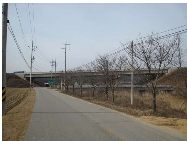
2공구 월가교 (2공구)
