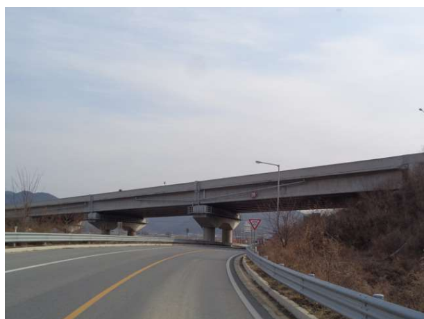
3공구 신계교 (3공구)
