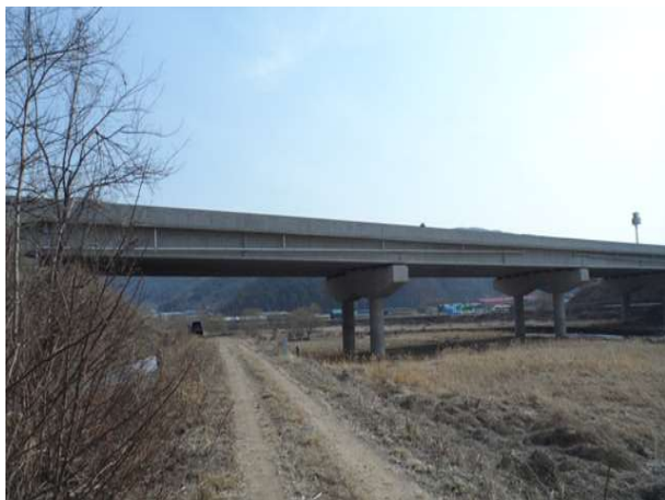
6공구 창기교 (6공구)
