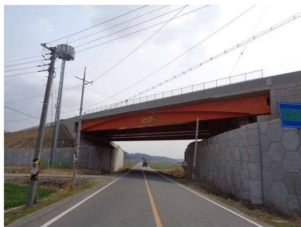
7공구 화남1교 (7공구)
