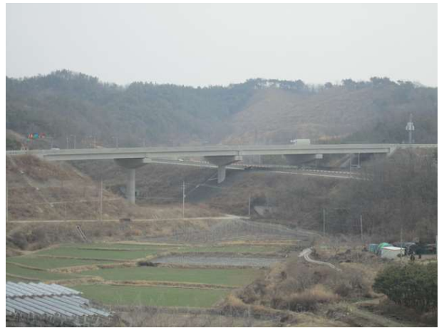
9공구 암기교 (9공구)
