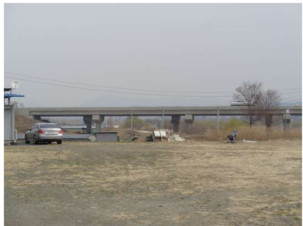
10공구 산하교 (10공구)
