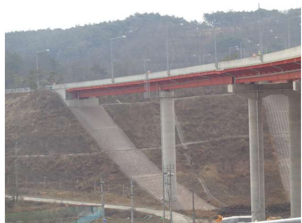
8공구 화산JCT RAMP-H교(8공구)
