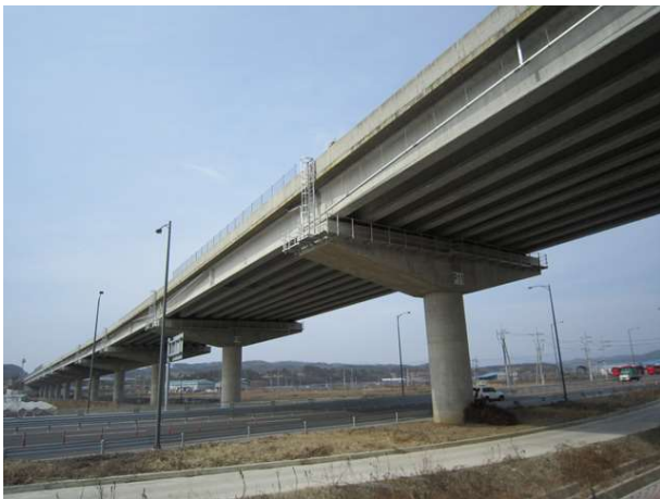
9공구 고현천교 (9공구)
